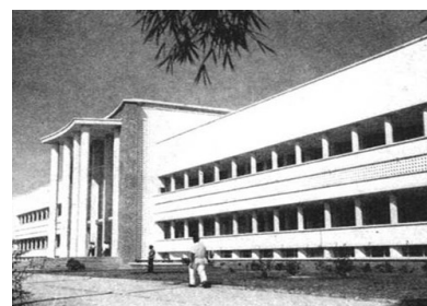
Troisième hôtel de poste de Kinshasa en 1951
