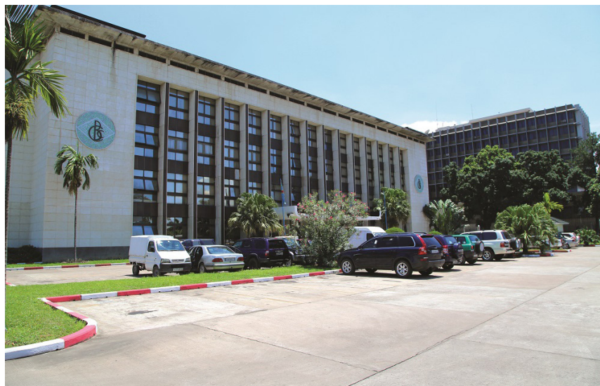
Le siège de la Banque Centrale du Congo à Kinshasa inauguré en 1976 Boulevard colonel Tshatshi Kinshasa – Gombe
