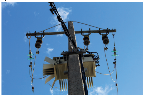
Figure 16 : Transformateur
