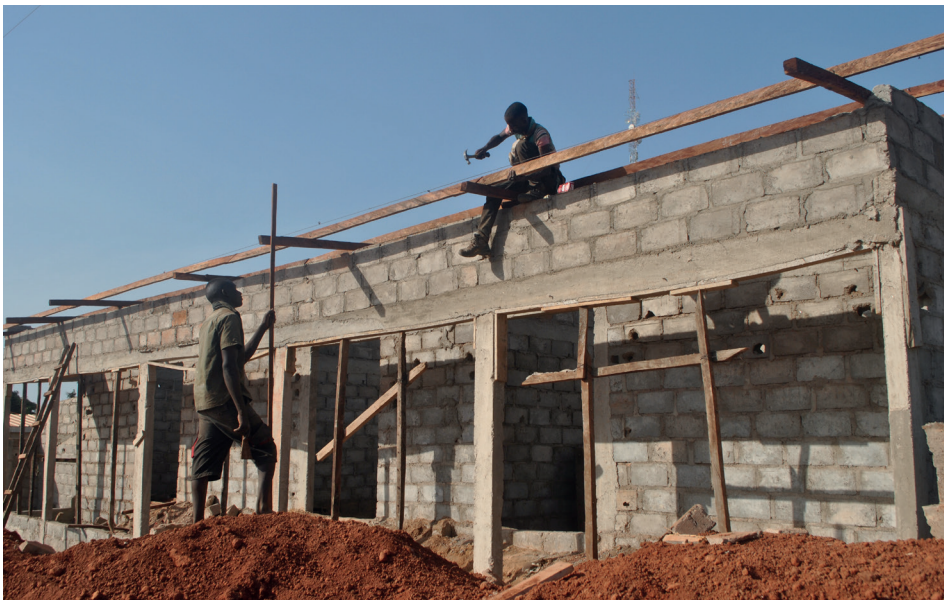
Figure 28 : Des maçons au travail à Ferkéssédougou (Côte d'ivoire)
