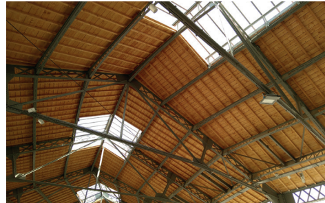
Figure 32 : Charpente en métal
