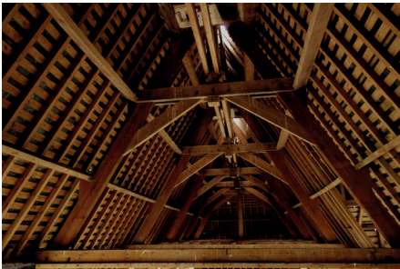
Figure 31 : Charpente en bois
