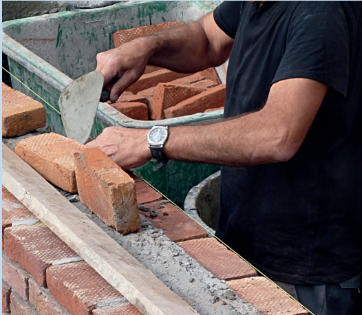
Figure 29 : Élévation d'un mur
