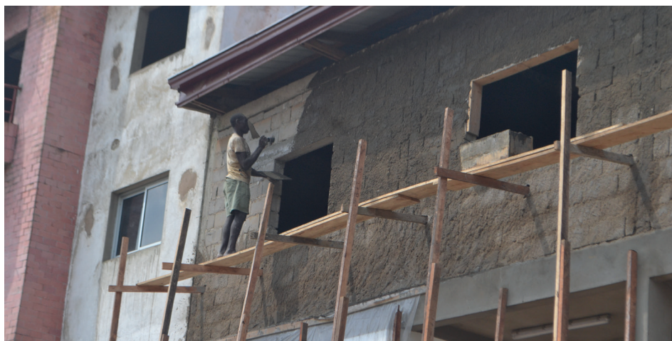
Figure 37 : Maçon au travail de crépissage d'une façade
